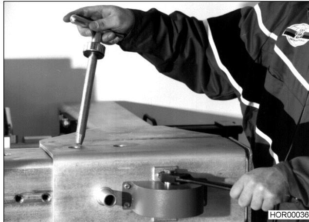
Bild 18 Positioning the right frame section
